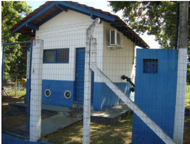
Foto 18 - EEAT Rua Groelândia
