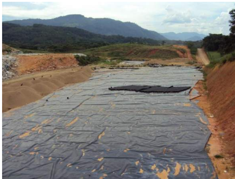
Foto 56 - Preparação de nova célula
