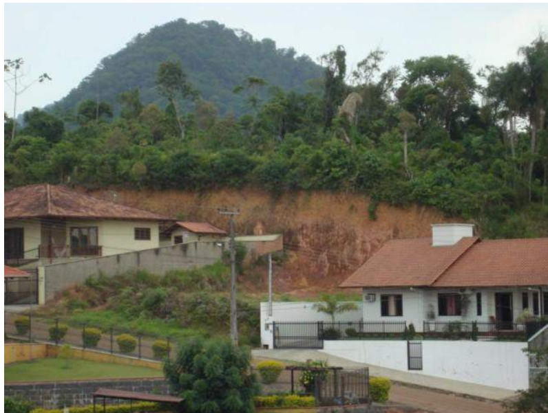
Foto 69 - Ponto com probabilidade de risco de deslizamento
