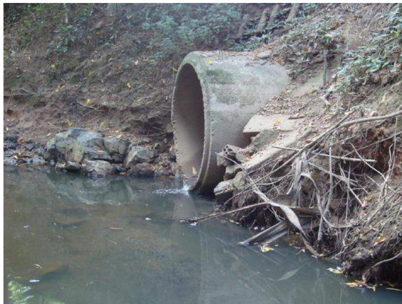
Foto 42 - Tubo coletor de drenagem/esgoto em Timbó
