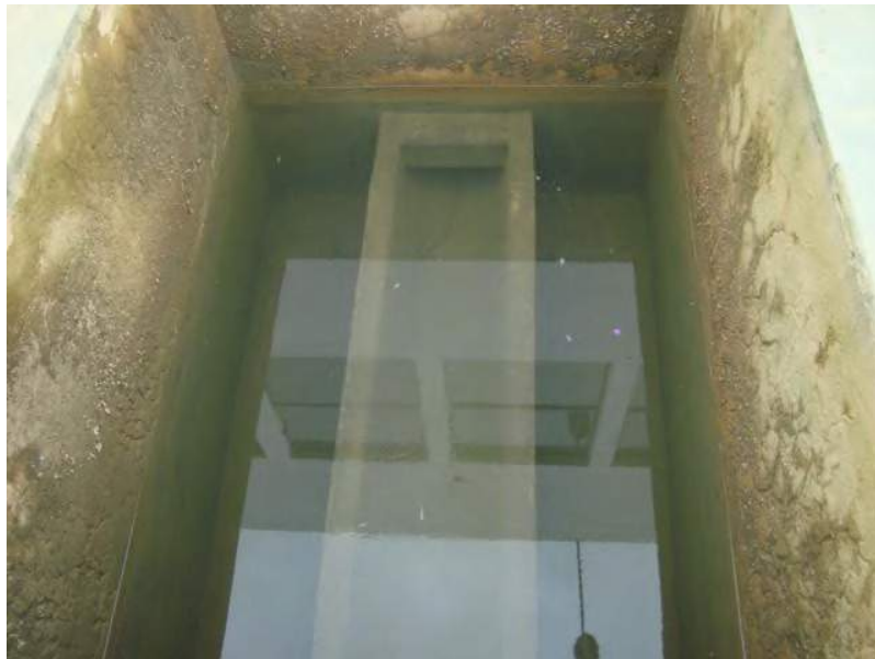
Foto 10 - Filtro rápido de duas camadas
