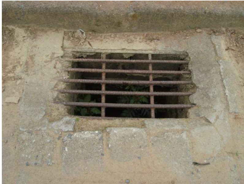
Foto 61 - Exemplo de boca coletora
