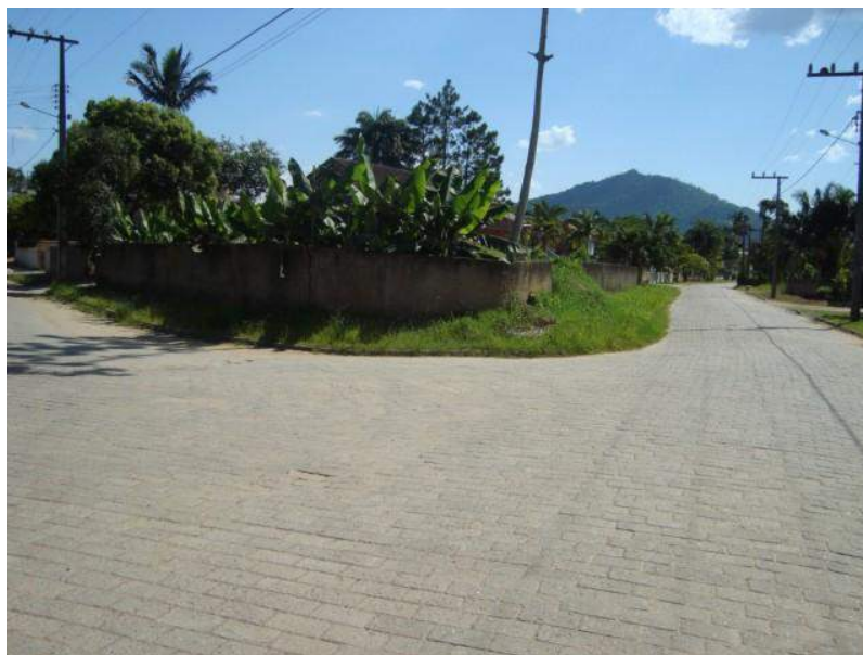
Foto 63 - Rua Haiti (Ponto de alagamento)
