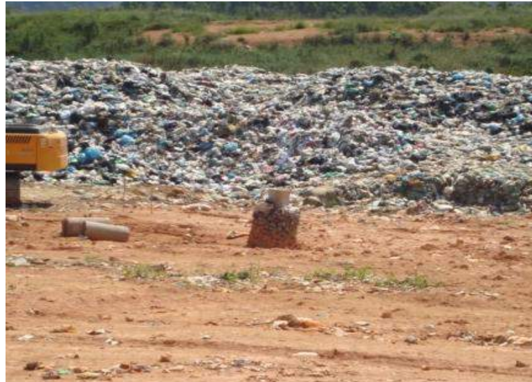
Foto 58 - Drenos de gás
