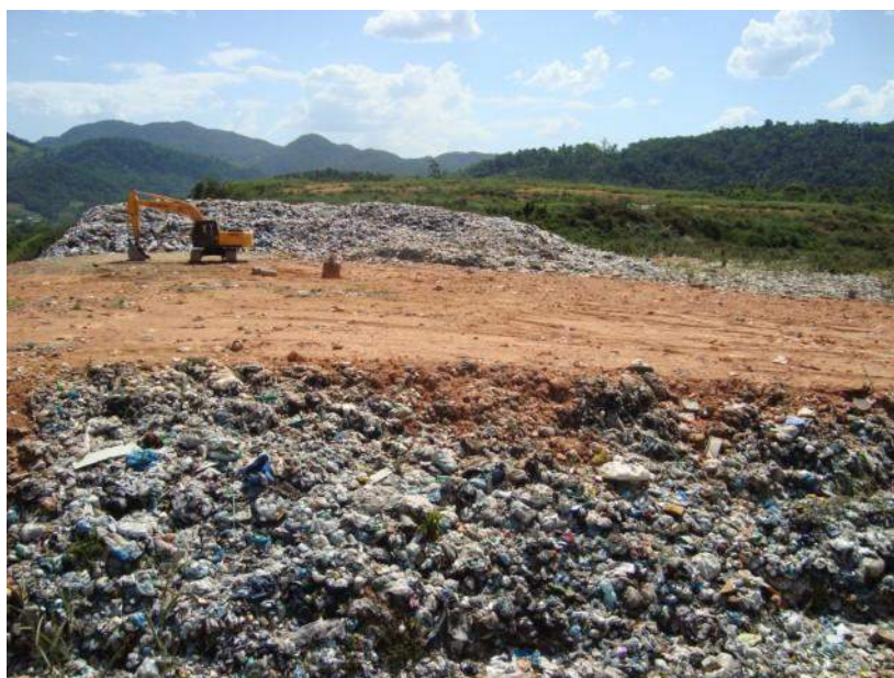
Foto 57 - Operação de compactação
