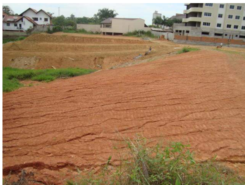
Foto 70 - Exemplo de terraplenagem no município
