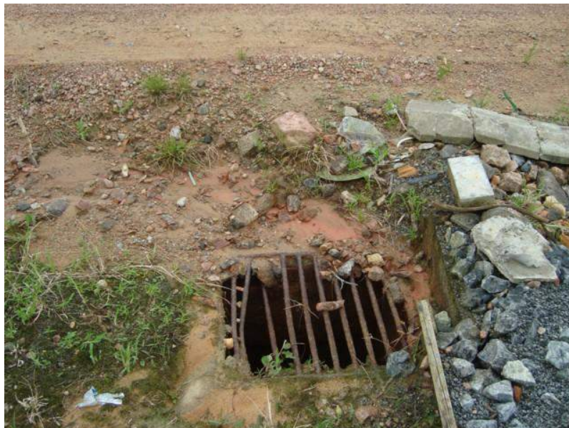
Foto 62 - Exemplo de boca coletora em via sem pavimento
