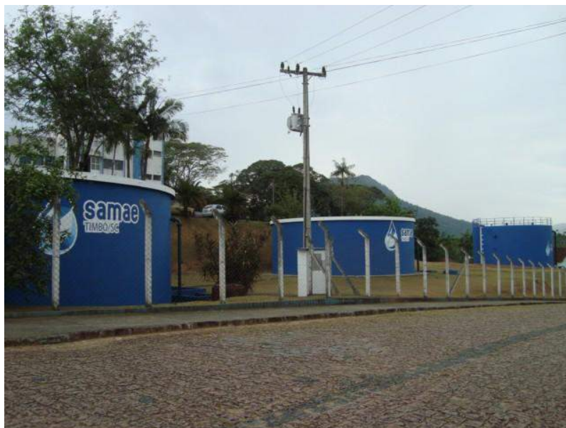
Foto 38 – Conj. de Reservatórios junto à ETA
