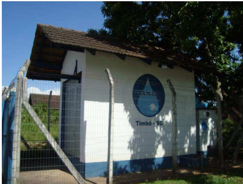
Foto 16 - EEAT Rua Quintino Bocaiúva
